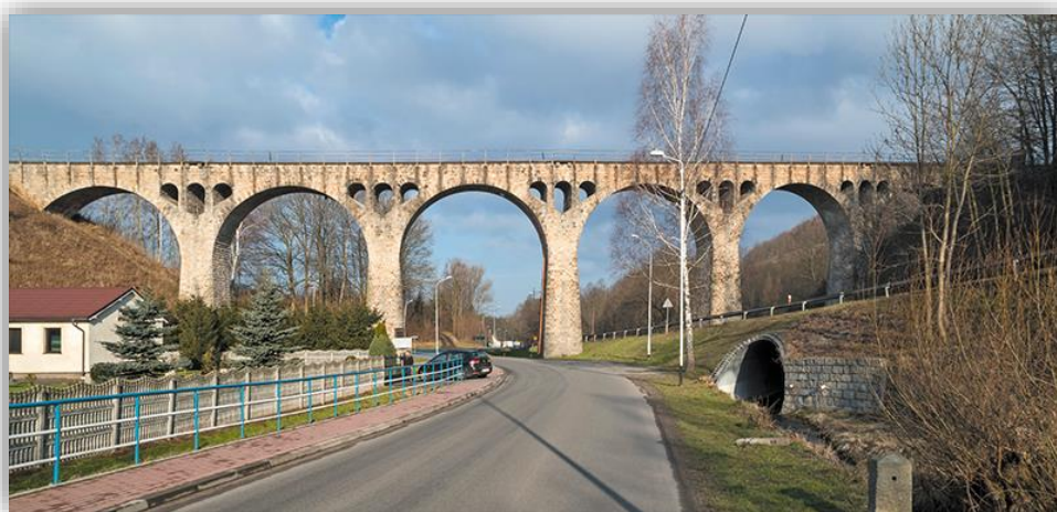
wiadukt kolejowy w Lewinie Kłodzkim
