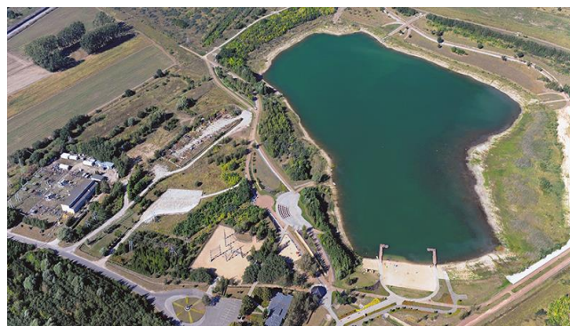
Park Rekreacji i Aktywności Fizycznej w Kleczewie
